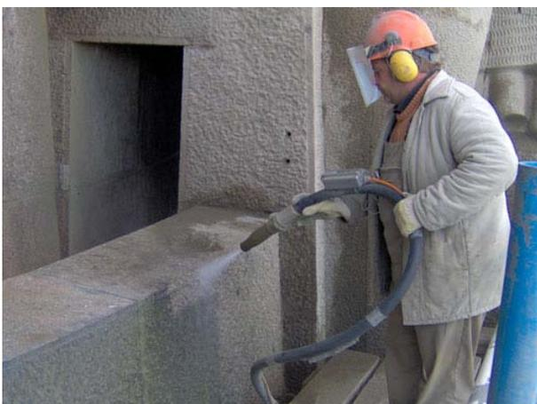
*„Die Einstellbarkeit von Luft, Wasser und Sand durch den Strahler ist von besonderer Bedeutung bei der Behandlung von empfindlichen Oberflächen.“*
